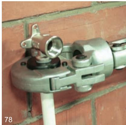
Производится опрессовка гильзы
