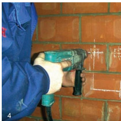
Высверливаются гнезда для крепления опор и водорозеток
