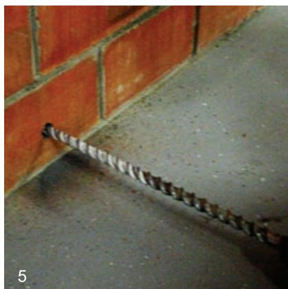
Пробиваются или высверливаются отверстия для прохождения трубы через стены и перегородки
