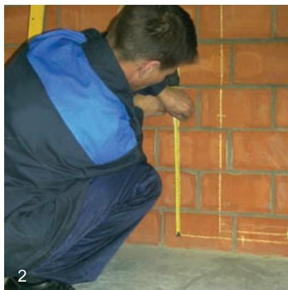
В соответствии с проектом намечаются места установки неподвижных и подвижных опор
