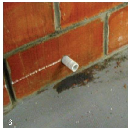
Устанавливаются гильзы из гофрированной трубы в отверстия стен и перегородок так, чтобы гильза выступала не менее, чем на 50 мм за грань конструкции
