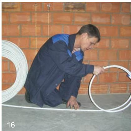
Вручную расправляется отмотанный участок трубы
